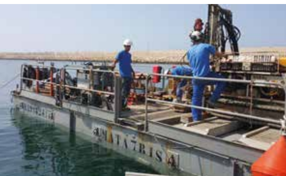
→ Investigations maritimes | Sondages carottés et essais mécaniques
