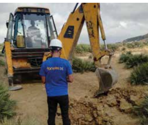
→ Investigations géotechniques | Sondages à la pelle mécanique
