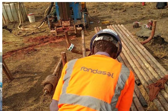
→ Investigations géotechniques | Sondages carottés avec essais SPT et pose de piézomètres pour suivi du niveau d'eau
