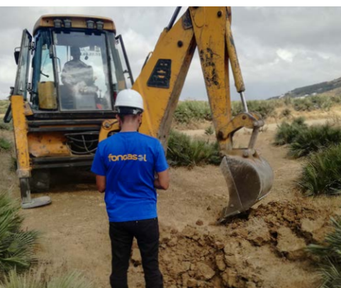
→ Investigations géotechniques | Sondages à la pelle mécanique
