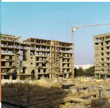
→ Projets de construction | Missions d'investigations, d'essais de laboratoire et d'ingénierie géotechniques
