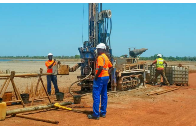
→ Projets d'infrastructures linéaires routières | Mission d'étude routière et de contrôle des travaux (Sédhiou)
